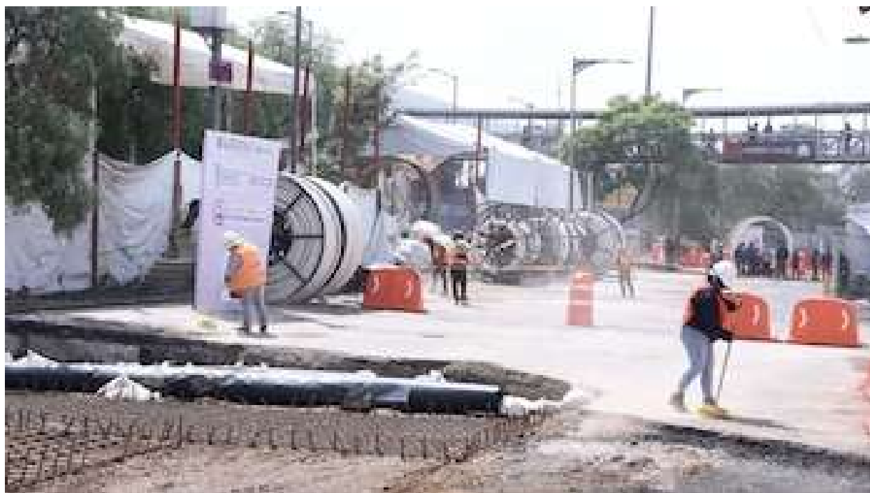
Imagen ilustrativa / Obreros trabajan en una excavación para infraestructura hidráulica en Iztapalapa, Ciudad de México, en el marco de un proyecto que busca combatir inundaciones en el oriente de la CDMX. (Jefatura Gobierno CDMX)
